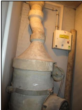
Photo N° 799 AMIANTE CIMENT 7 LORIENT--LOCAL V.O +1 à +8 Vide- ordures Gaine V.O.(Fibres-ciment)
