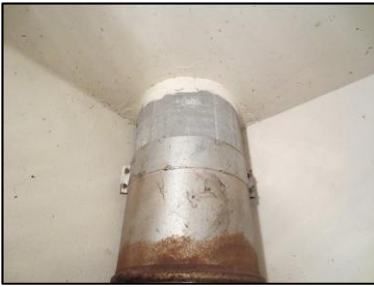
Photo N° 685 AMIANTE CIMENT 7 LORIENT-RDC-V.O Vide-ordures Gaine V.O.(Fibres-ciment)
